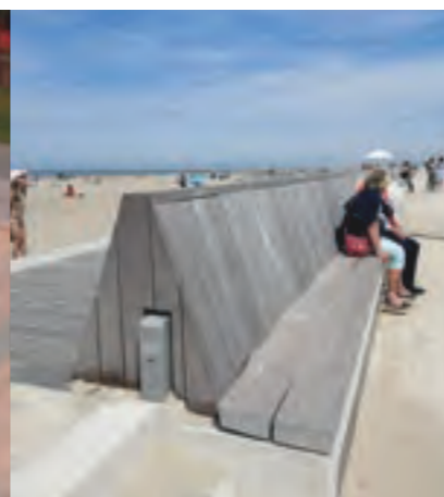
Digue de Malo - Dunkerque
